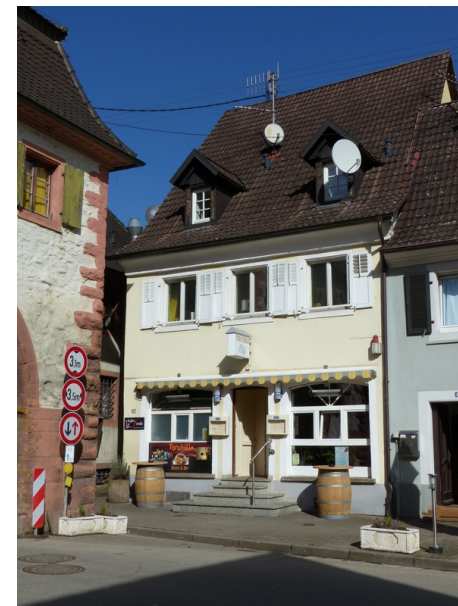
Ansicht von SW
