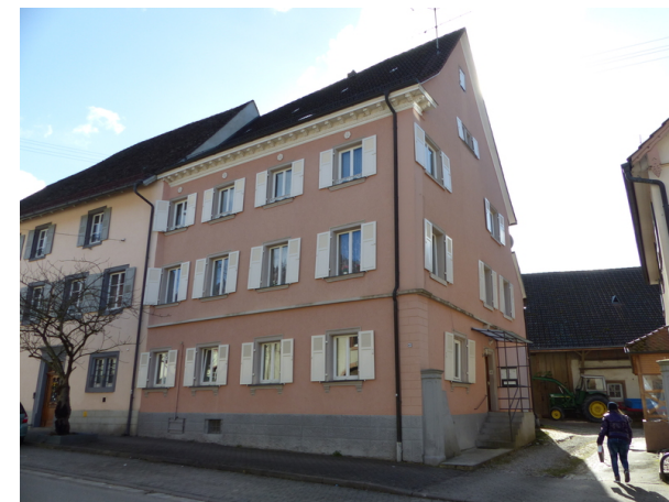
Ansicht von NO
