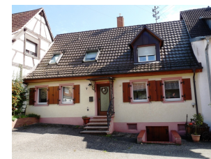
Ansicht von NW
