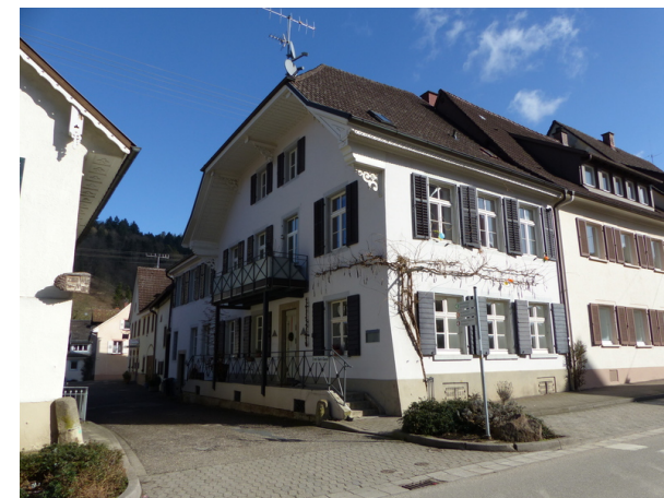
Ansicht von W
