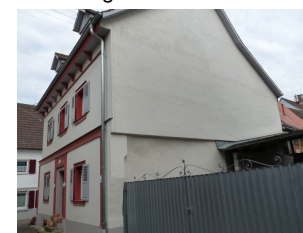
Ansicht von SW
