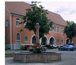
Hauptstraße 60, vor / Marktbrunnen
