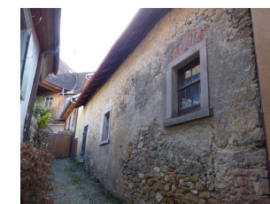
rückwärtige Scheune, Ansicht zwischen Klostergasse 6a und 8 nach SO
