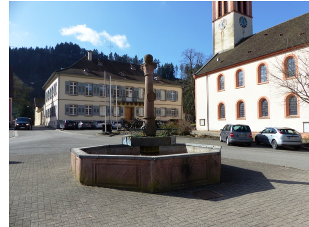
Ansicht von NW
