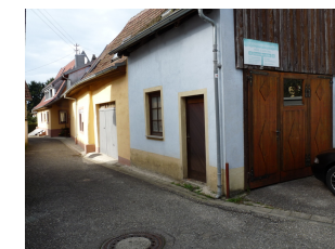
Ansicht von SO auf Höhe der Gustav-Weil-Straße 11
