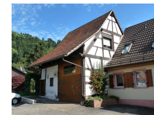
Scheune, Ansicht von W
