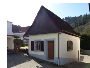
rückwärtiger Ökonomiebau, Ansicht von NO
