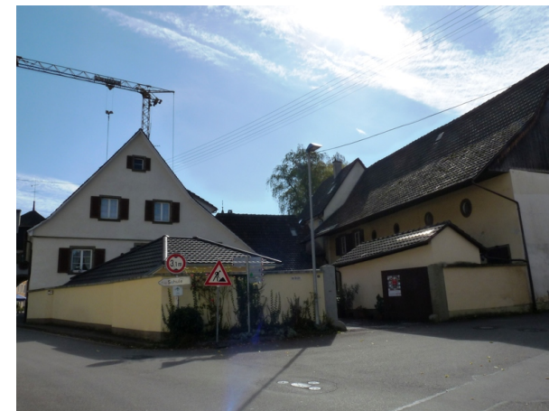
Ansicht von NW
