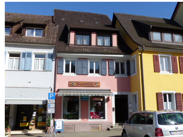
Ansicht von SW
