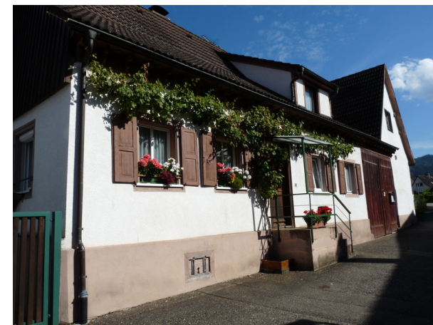
Ansicht von SW
