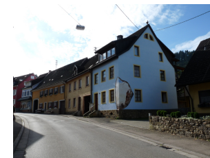
Ansicht von NW
