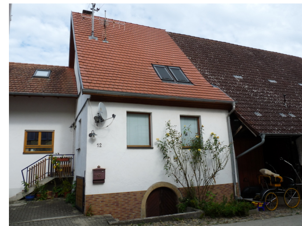
Ansicht von SW
