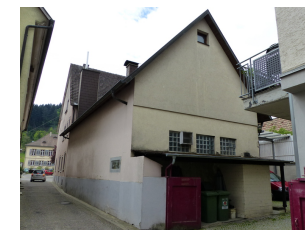
Rückgebäude, Ansicht von NO
