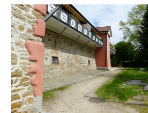
Südlicher Stadtgraben, Ansicht von W
