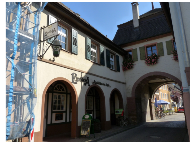
Ansicht von SW
