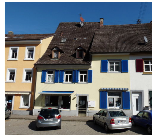
Hauptstraße 47 mit Eingang von 47a, Ansicht von SW
