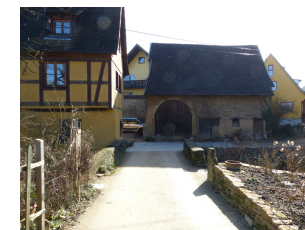
Bogenbrücke bei Hauptstraße 26a, Ansicht von NW
