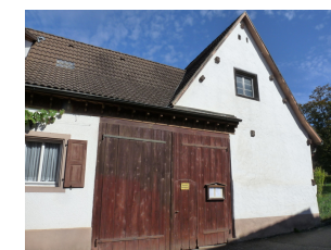
Ökonomieteil, Ansicht von SW
