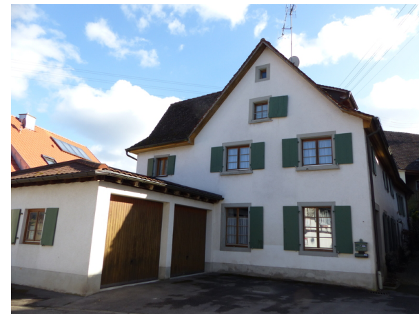
Ansicht von NW
