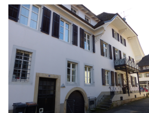
Ansicht von NW
