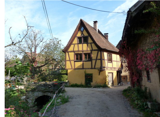
Nebengebäude Hauptstraße 26a, Ansicht von SW
