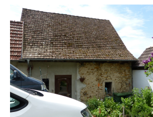
Rückgebäude, Ansicht von W
