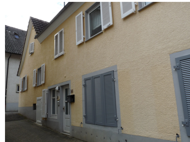
Ansicht von NO
