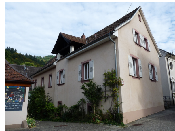
Ansicht von SO
