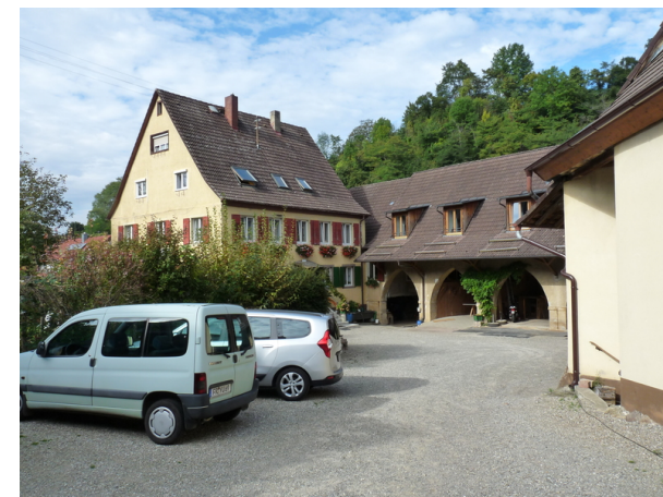
Innenhof, Ansicht von SO
