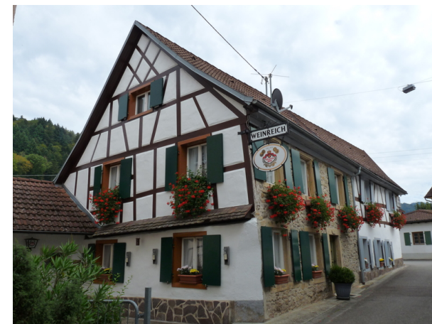
Ansicht von W
