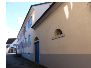
Ansicht von NW
