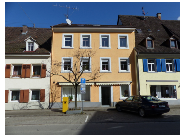
Ansicht von SW
