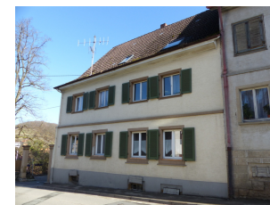
Ansicht von SW
