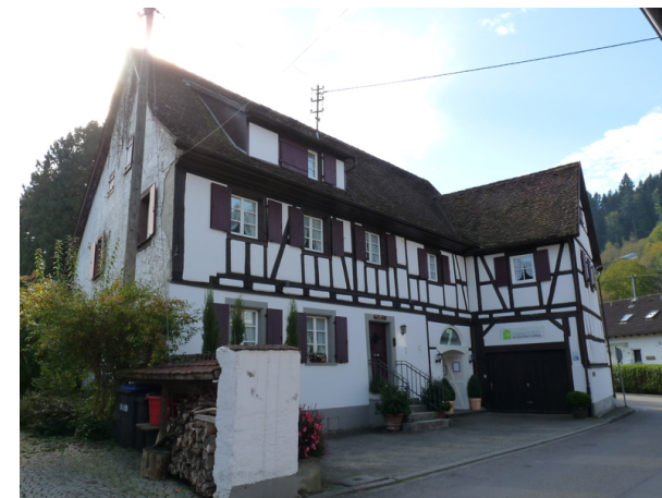
Ansicht von NW
