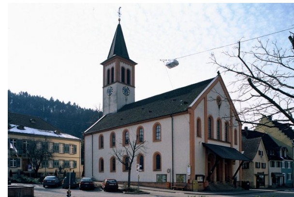
Hauptstraße 56 - Bergbaumuseum, ehem. ev. Stadtkirche
