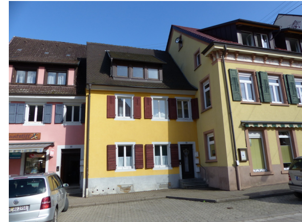
Ansicht von SW
