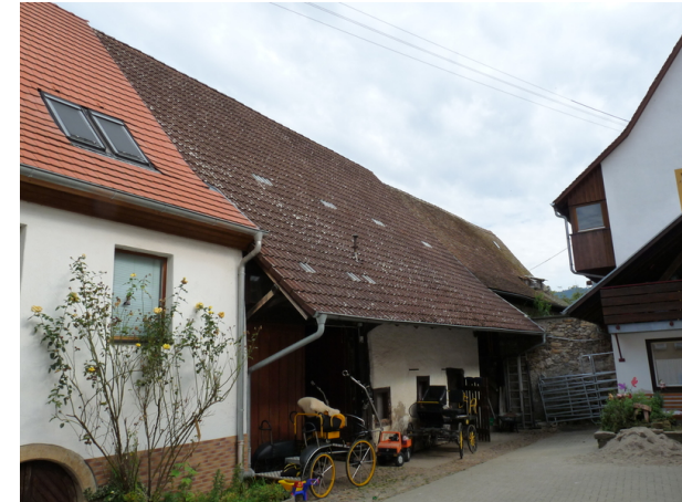
Ansicht von W
