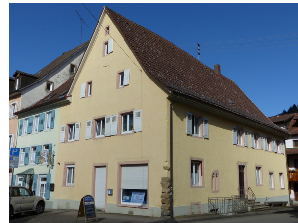
Ansicht von SO
