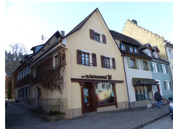
Ansicht von SO
