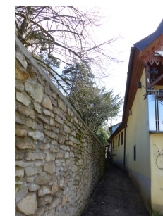
Ansicht von NW
