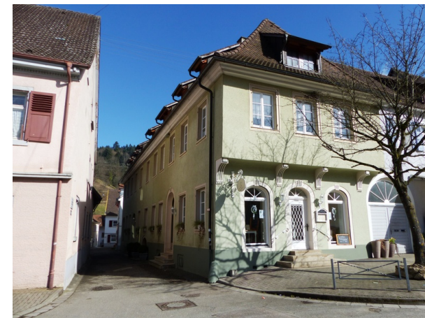
Ansicht von SW
