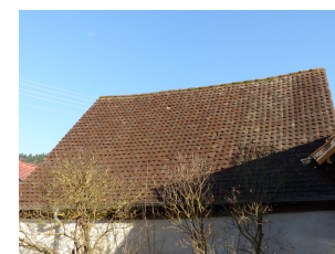
rückwärtige Scheune, Ansicht von W
