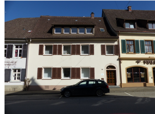
Ansicht von SO
