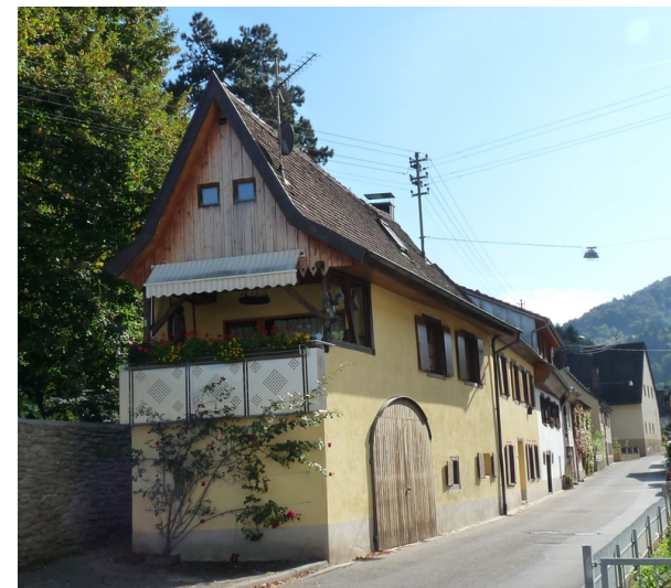
Ansicht von W
