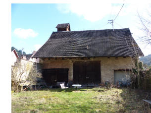
rückwärtige Scheune, Ansicht von W
