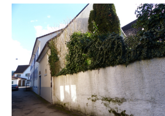
Ansicht von NW
