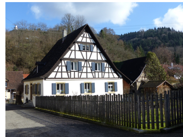
Ansicht von SW
