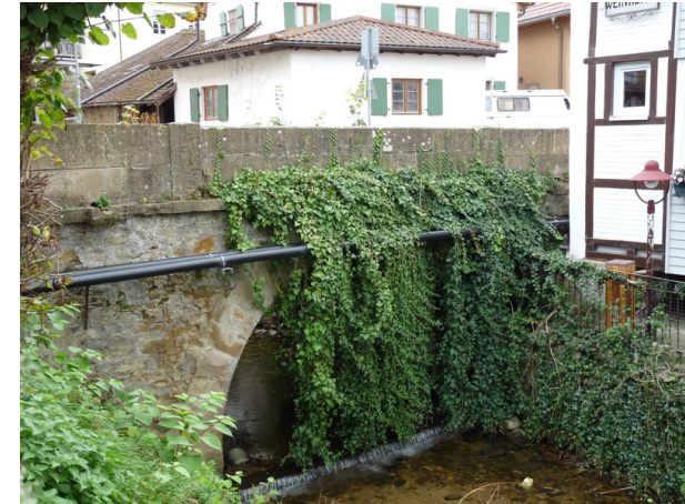
Brücke Klostergasse, Ansicht von NW
