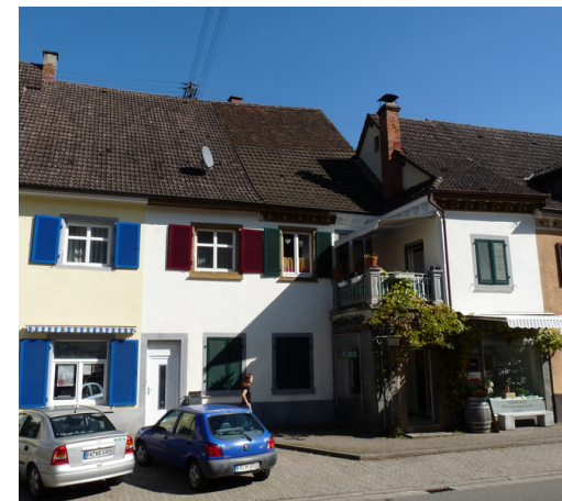
Ansicht von SW
