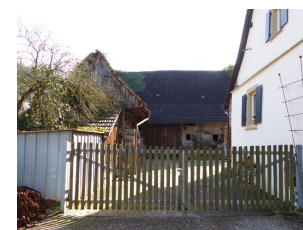
Hofeinfahrt mit Scheune, Ansicht von NW
