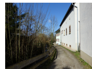
Ansicht von SO
