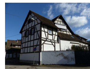
Ansicht von SW
