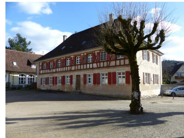
Ansicht von NW
