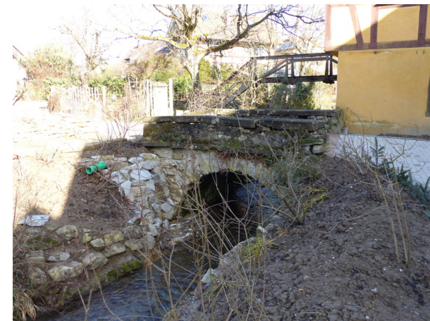
Bogenbrücke bei Hauptstraße 26a, Ansicht von S
