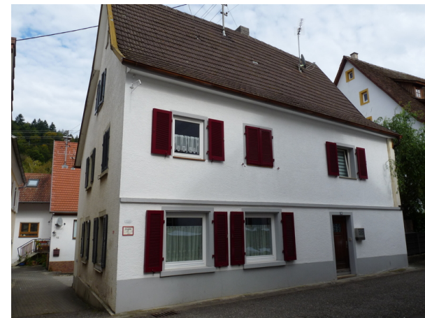
Ansicht von W
