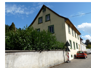
Ansicht von W
