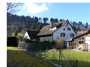
Ansicht von NW
