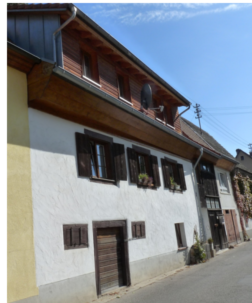
Ansicht von SW
