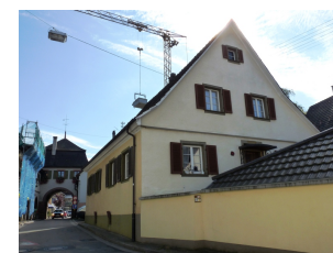
Ansicht von NW
