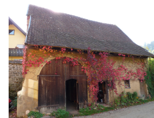
Scheune von Hauptstraße 26a, Ansicht von NW
