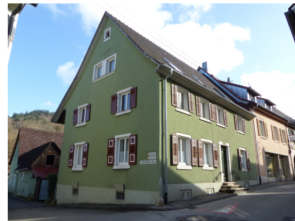
Ansicht von W
