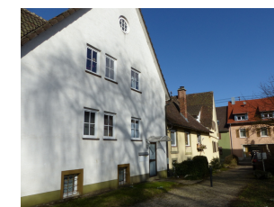
Ansicht von SO
