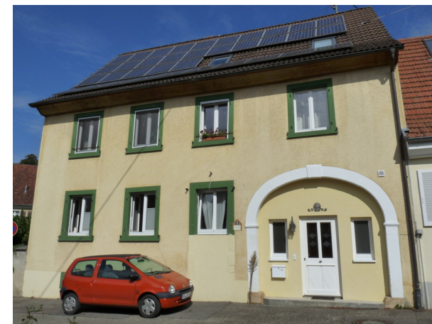
Ansicht von SW
