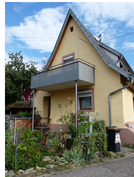
Ansicht von NW
