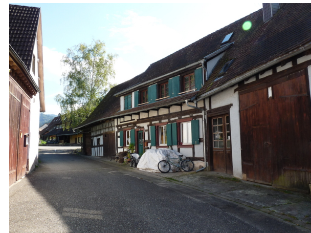
Ansicht von NW
