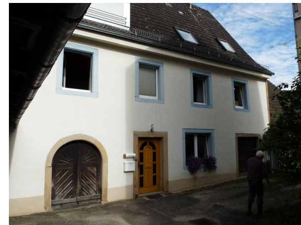
Ansicht von SW
