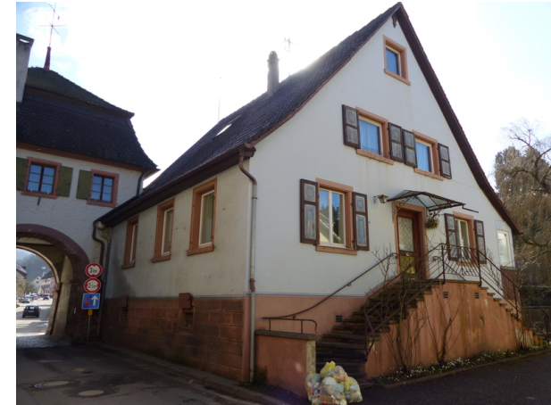
Ansicht von W
