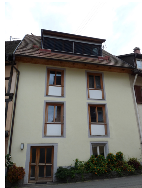
Ansicht von NW
