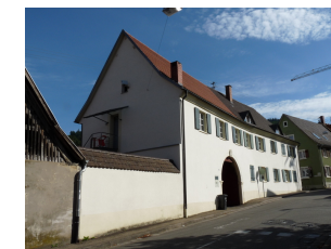
Ansicht von SW
