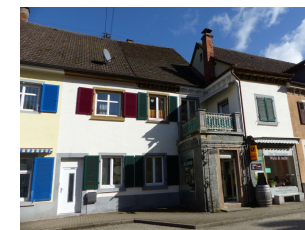
Hauptstraße 47a, Ansicht von SW
