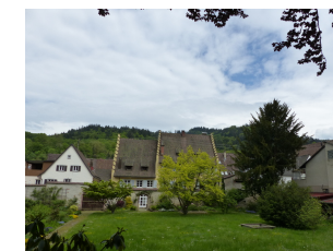
Ansicht von SW
