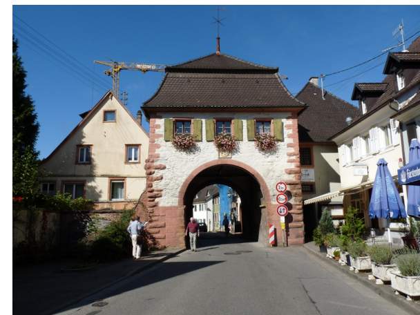
Ansicht von SO
