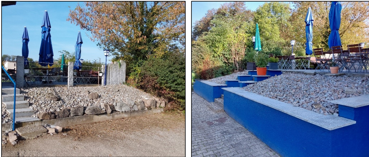
Abb. 6 + 7: Steinschüttungen entlang der Terrasse der Sportgaststätte.
