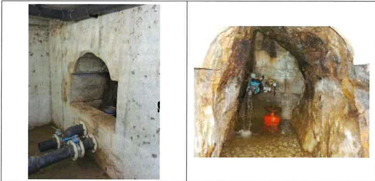
An dem Auslauf der Quelle ist ein Wasserzähler angebracht, dieser wird jedoch nur sehr selten abgelesen und ist nur durch das Quellsammelbecken begehbar.
