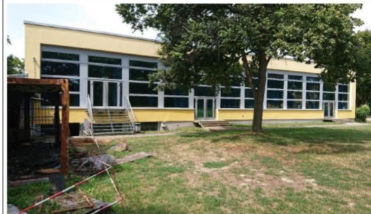
Abbildung 3: Blick auf die Rückseite der Turn- und Festhalle, mit den Zugängen zum Untergeschoss links im Bild (südöstliche Gebäudeseite)
