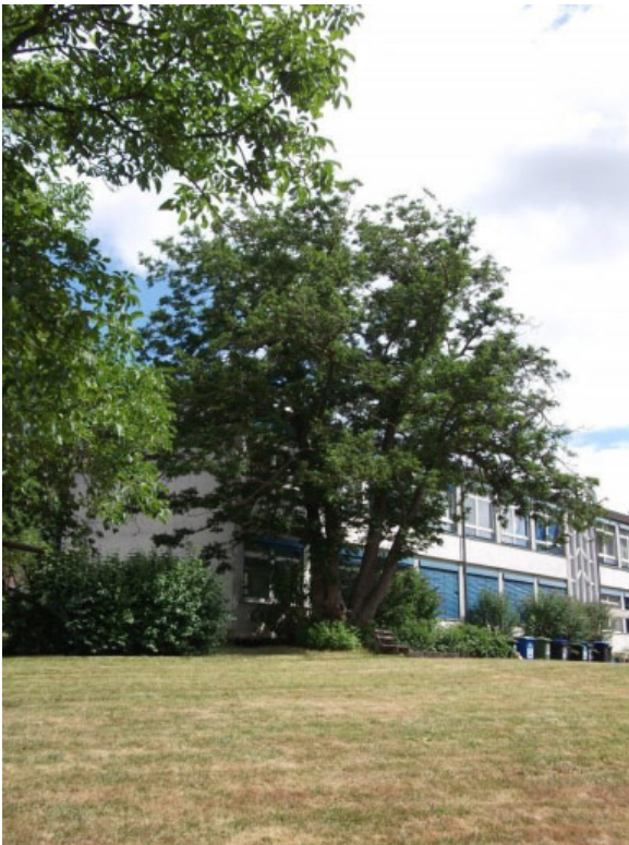
2. Südfront des ehem. Schulgebäudes mit 8 Sperlingsnestern unter den Rolladenverkleidungen
