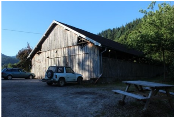
Abbildung 13: Scheune des Forstamtes
